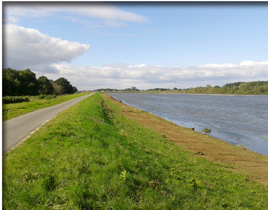
Digue de Sully-sur-Loire - Crédit-photo : DDT 45 / Loire
